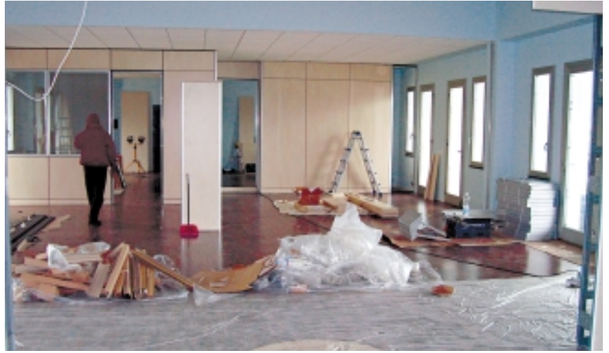
La nuova sede in corso di allestimento.
